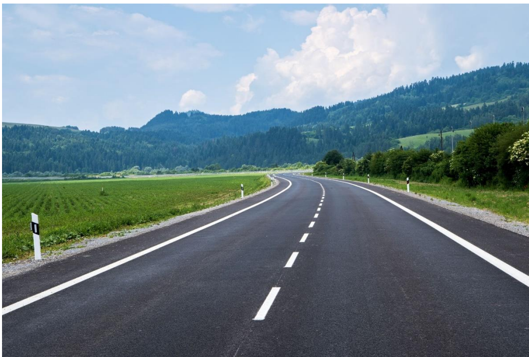
stavba: I/68 Plavnica, preložka cesty
