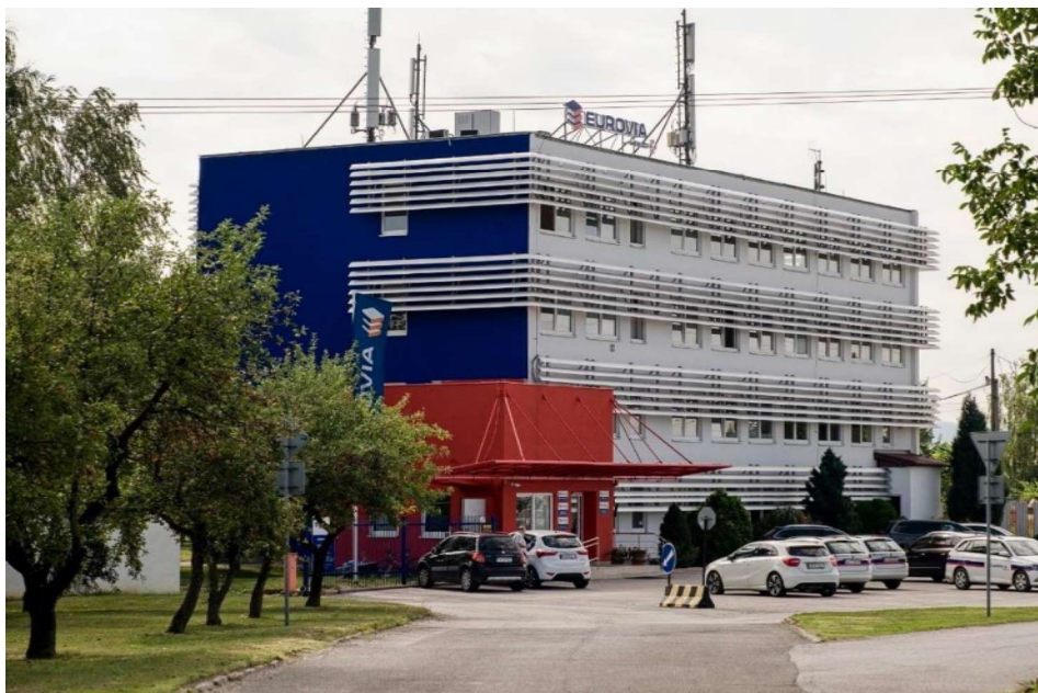
obr: administratívna Budova -Riaditeľstvo Košice
