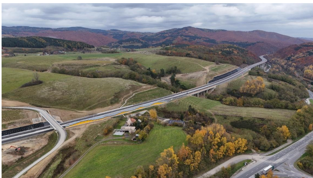
Stavba: R2 Kriváň - Mýtna
